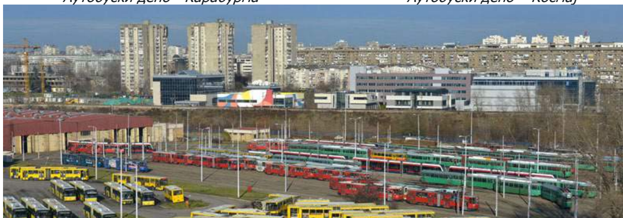
Трамвајски депо - Нови Београд
